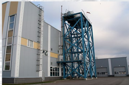
Мосводоканал «Завод по производству гидрохлорида натрия»
